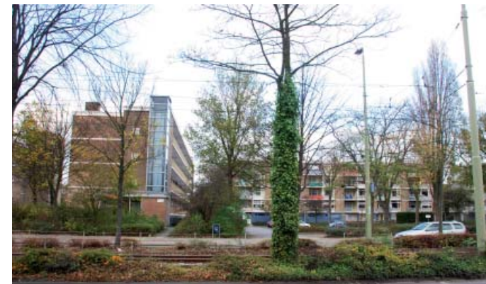
de naoorlogse galerijflats staan haaks met open terreinen ertussen aan de Loosduinse Vaart
